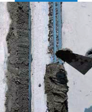
Нанесение раствора мастерком
