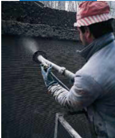
Механизированное нанесение методом мокрого торкретирования
